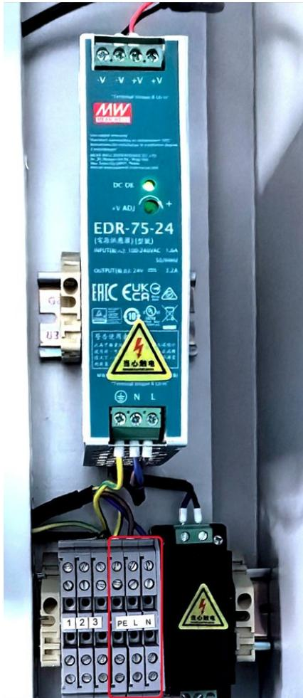
230 VAC 电源线连接到机柜内部的接头，如左图所示。
