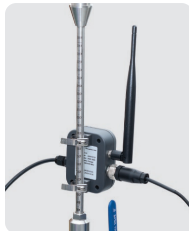
传感器测量杆安装
